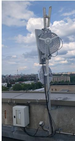
Abbildung 10: Freifunk-Richtfunk-Installation am ehemaligen Flughafen Tempelhof, die hier zur Illustration des von uns Angedachten dienen soll und die Größen von Richtfunkantennen zeigt. Zu sehen sind am Mast mehrere Typen von Richtfunkantennen und der Schaltkasten mit dem Core-Router und dem Switch. Vgl. [https://wiki.freifunk.net/Berlin:Standorte:Flughafen\\_Tempelhof](https://wiki.freifunk.net/Berlin:Standorte:Flughafen_Tempelhof).
